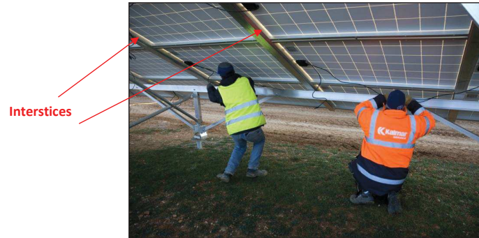
Illustration 1 : Vue des interstices entre chaque panneau (Source : IEL)
