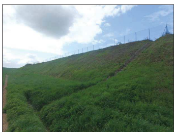
Caniveau présent au niveau du talus.
