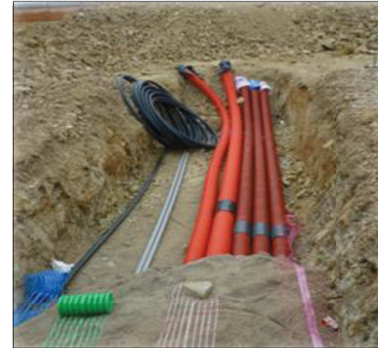
Photo 4 : Câblage sur site entre les postes électriques
