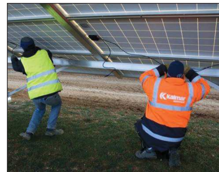
Photo 1 : Câblage des panneaux photovoltaïques
