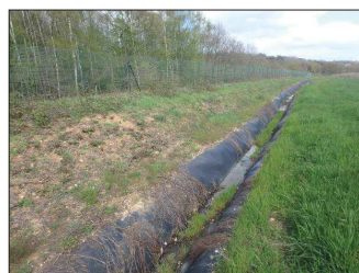
Fossé en géomembrane.
